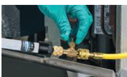
Befüllung mit dem Kältemittel
