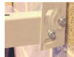
Schnelle Installation der Halterung durch Scharnierarme
