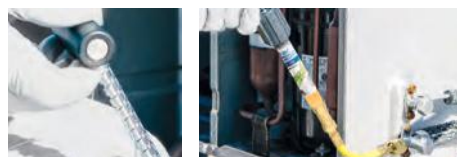
Injection du colorant en tournant la poignée.
