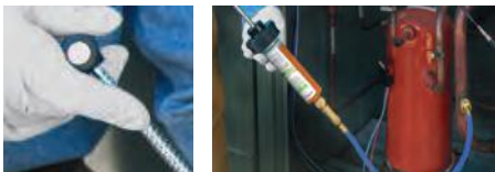
Injektion des Färbemittels durch Drehen des Griffs.
