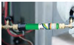
Befüllung mit dem Kältemittel
